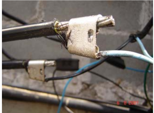
Conector protegido com CorrosionX
